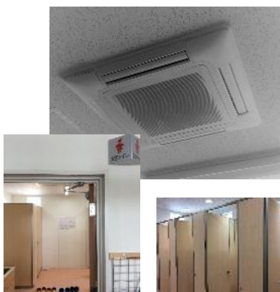
冷暖房設備完備、トイレ改修工事竣工 （学校環境の整備・充実）
