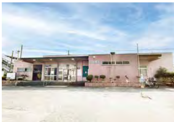
▲現在の一日の延べ利用者は約 1,300 人余り。時代は変わっても、新田原駅は地域の記憶を刻み続けている。
