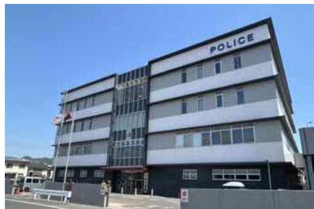
▲地上4階建。約170人の警察官が日々勤務にあたり、地域の安心・安全を守る。4階には心身を鍛錬するために武道場を備えている。
