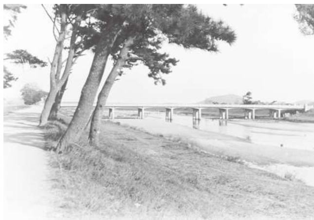
▲現在の今川橋の北側より今川と完成したばかりの豊国橋を眺めた古写真。今川の土手（現在の福岡県道 34 号行橋添田線）は未舗装であることが分かる。豊国橋の後にみえる山影は沓尾山。
