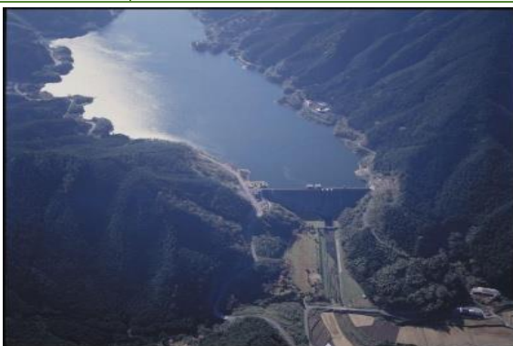
油木ダムの全景
