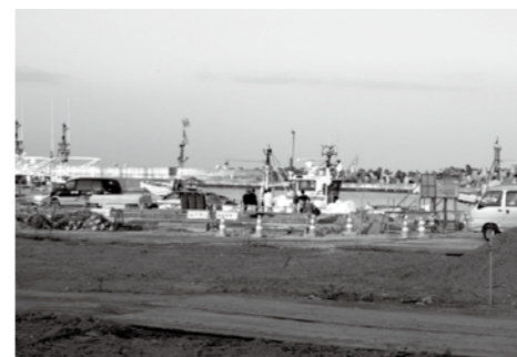
復旧工事が進む磯浜漁港。
