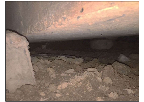
PC 主桁下面の遊離石灰と、橋台底版下面の土砂流出(2258_小鳥跨道橋) :調査中
