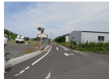
E. 市道寄原・下寄原線 電柱／カーブミラー／照明灯／道路標識／道路防護柵／水路／側溝升
