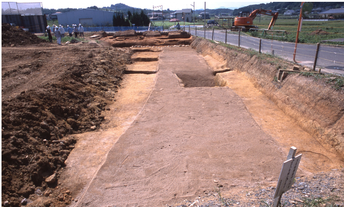
図4-1-2 遺構保護層施行状況 九州歴史資料館提供
