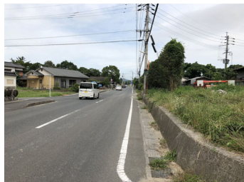
D. 県道長尾稗田平島線 電柱／カーブミラー／照明灯／道路標識／道路防護柵／水路／側溝升
