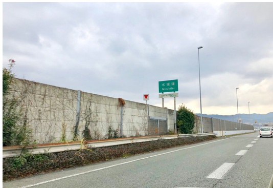
図 8-2-24 東九州自動車道走行者に本史跡の 位置を示す看板 （水城跡／九州自動車道）
