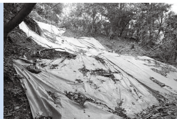
駐車場からの参道の 土砂崩れの様子
