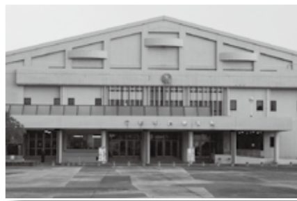
▲行橋市民体育館
