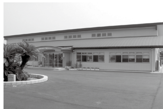
●平成 16 年 5 月、行橋市の高齢者福祉を支える専門職や地域の人材育成の拠点施設として地域ケア複合センターを開設しました。
