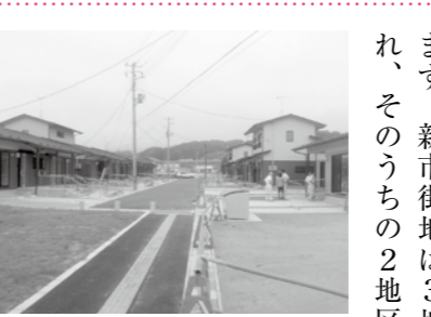
完成した災害公営住宅。
